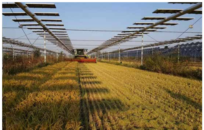
Bild 39: Hoch aufgeständerte Anlagen mit schmalen PV-Modulen. © REM Tec
