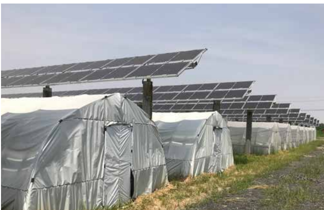
Bild 36: PV-Module über einem Folientunnel. © BayWa r.e.
