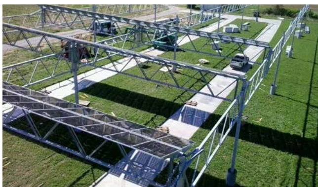
Bild 48: Baustraßen zur Vermeidung von Bodenverdichtung. © BayWa r.e.
