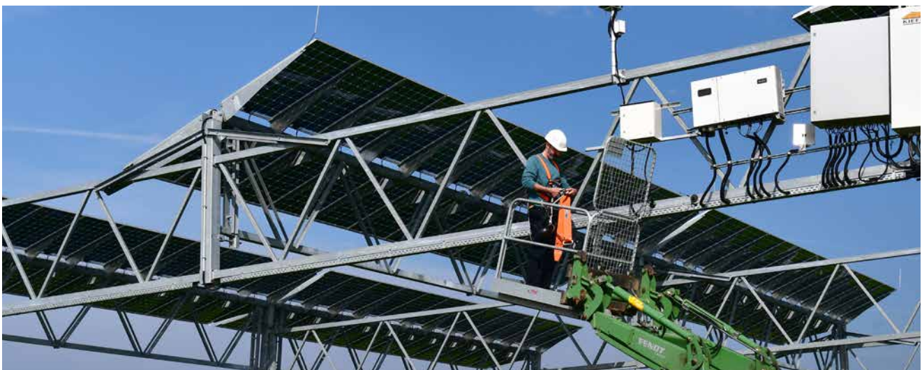
Bild 49: Wartungsarbeiten an der Agri-PV-Anlage in Heggelbach.
