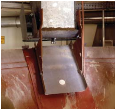
Sensor Litronic-FMS II in Materialrutsche eingebaut.
