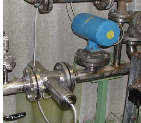
Schallsensor in einem Polymerisations - Reaktor Schallsensor und Refraktometer in einer Rohrleitung
