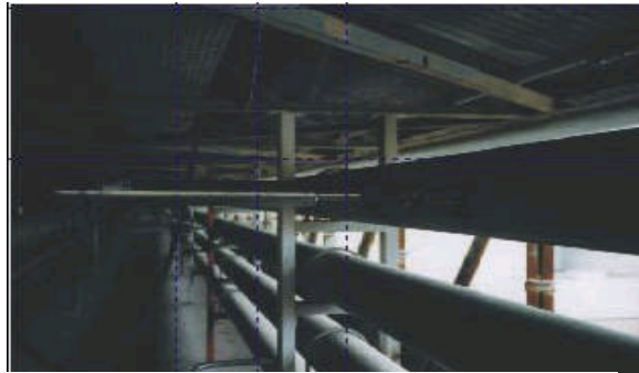
Messung in einer Zuleitung
