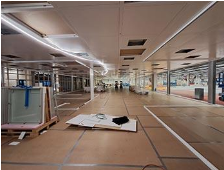
Bildunterschrift Bild 3 und 4: Montage der Reinraumwände
