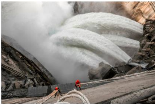
Die Staumauer von Wudongde von oben
