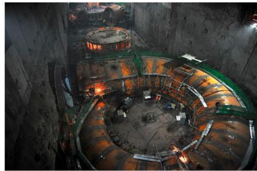
Überdimensionale Rohre im Inneren der Staumauer
